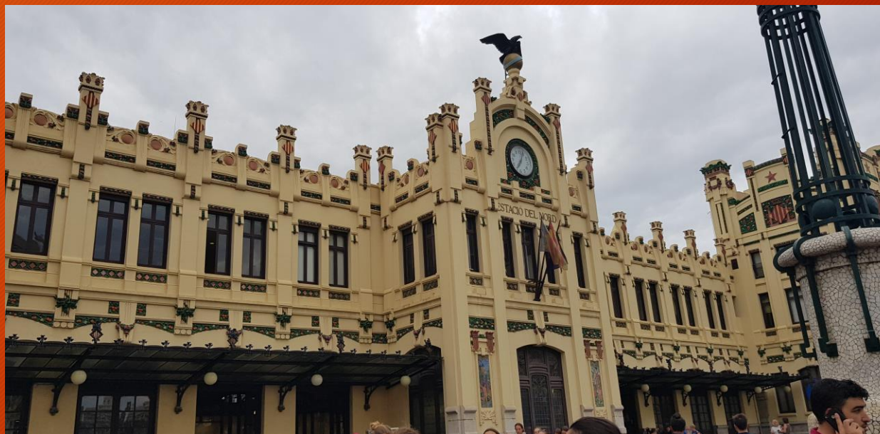
Dworzec w Walencji wybudowany w 1917 r.
